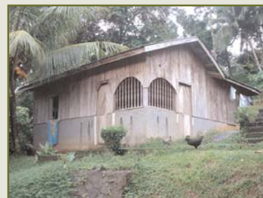
Septiembre 2004. Casas de El Castillo atendidas por el programa de vivienda antes y después de la intervención
