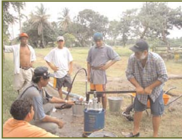
Octubre 2003. Realización de la prueba hidrostática del sistema de agua potable
