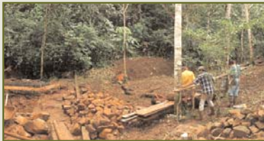
Agosto 2004. Trabajos de reforma de la captación de La Ceiba
