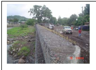
Inauguración del Muro de contención en la Rivera del Río Matagalpa, de 250 metros lineales.
