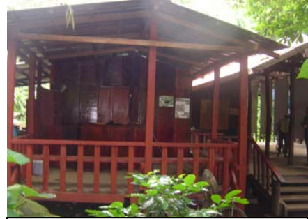
Caseta rehabilitada del área protegida en comanejo – reserva natural Chocoyero.
