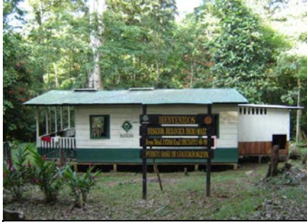
Puesto Dos Bocas de Bartola /RSJ rehabilitado y ampliado.
