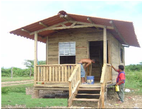
Caseta de control ubicada en salinas grande del área protegida en comanejo – reserva natural Chocoyero.
