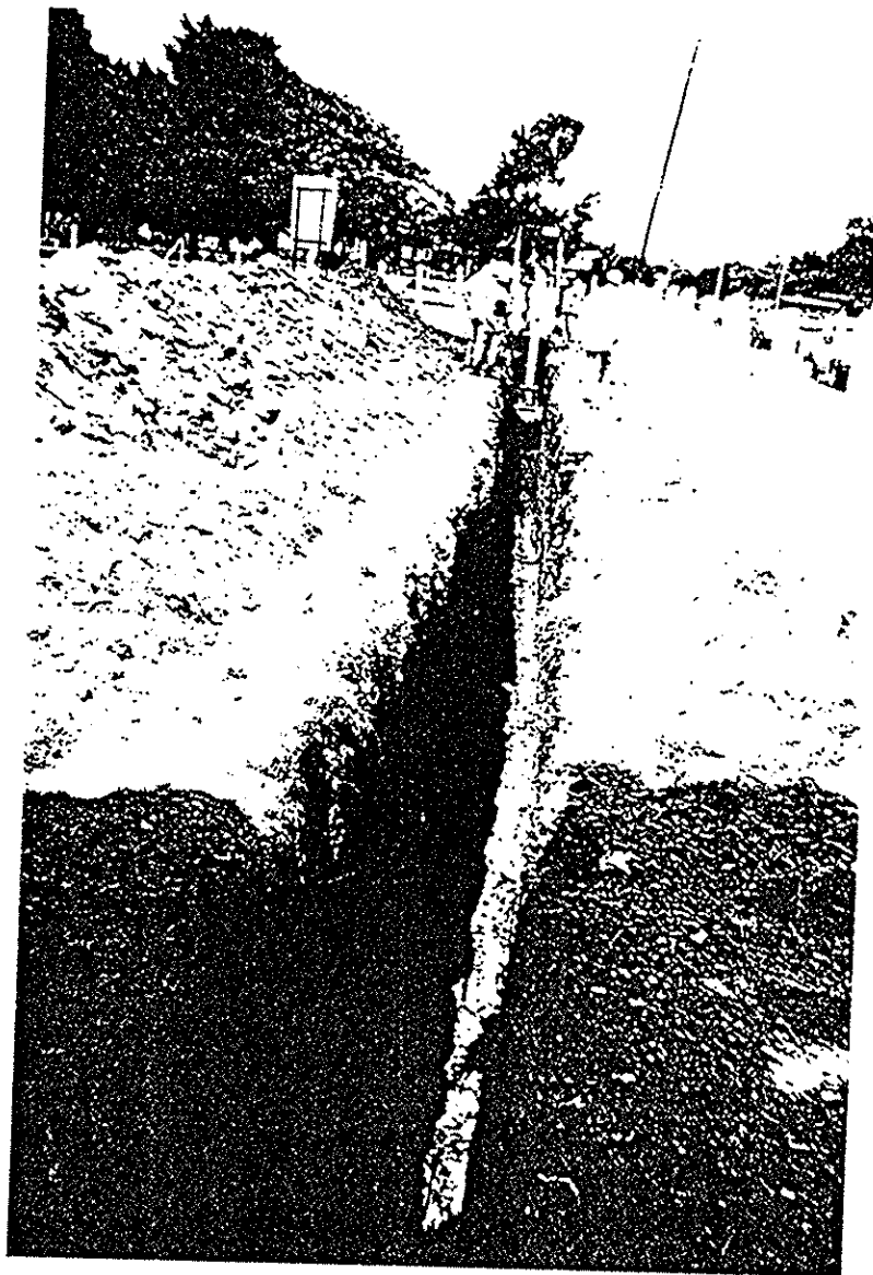
Zanja A-A' desde el Oeste
