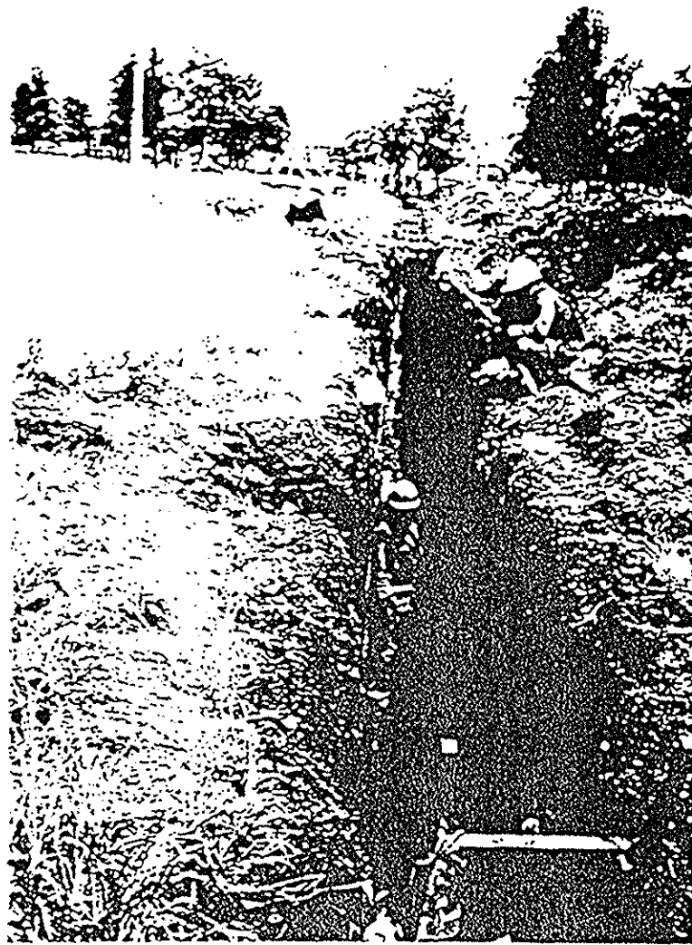
Trinchera geológica exploratoria A-A' del terreno del Proyecto de Construcción del Edificio de La Cancillería de la República de Nicaragua
